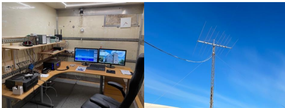
Kuvissa etäasema ja uuden antennin asentaminen.
